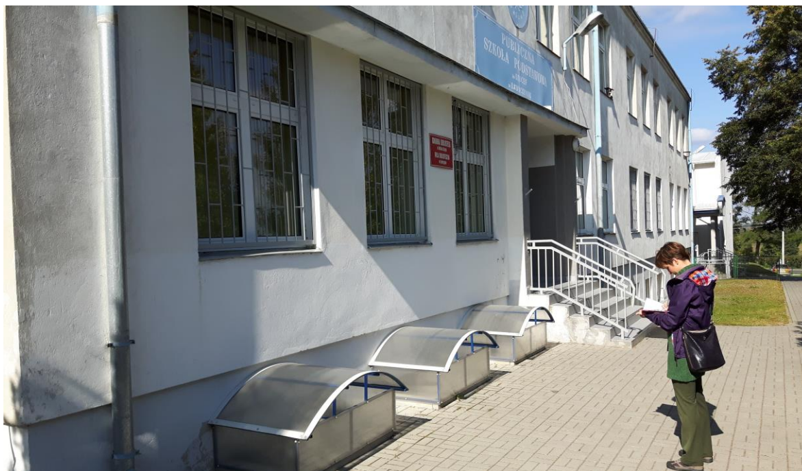
Zdjęcie nr 1 – Elewacja wschodnia (front budynku – wejście główne)
