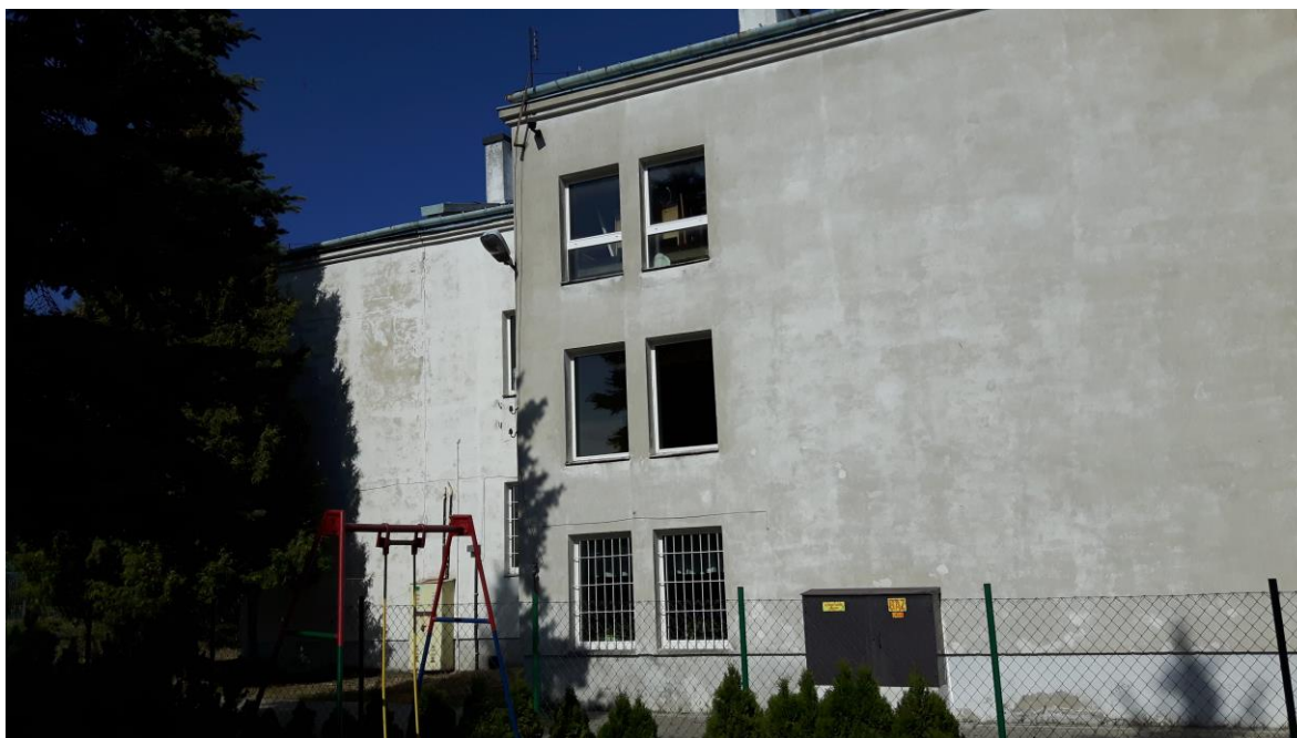
Zdjęcie nr 5 – Elewacja południowa
