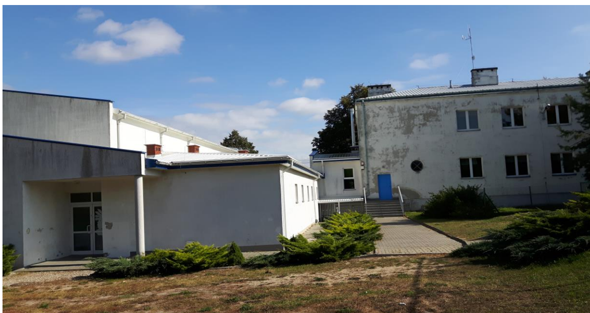
Zdjęcie nr 4 – Elewacja zachodnia
